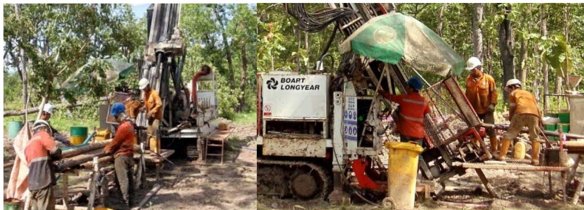
Fig. 4: Kratie North – Drill rig
