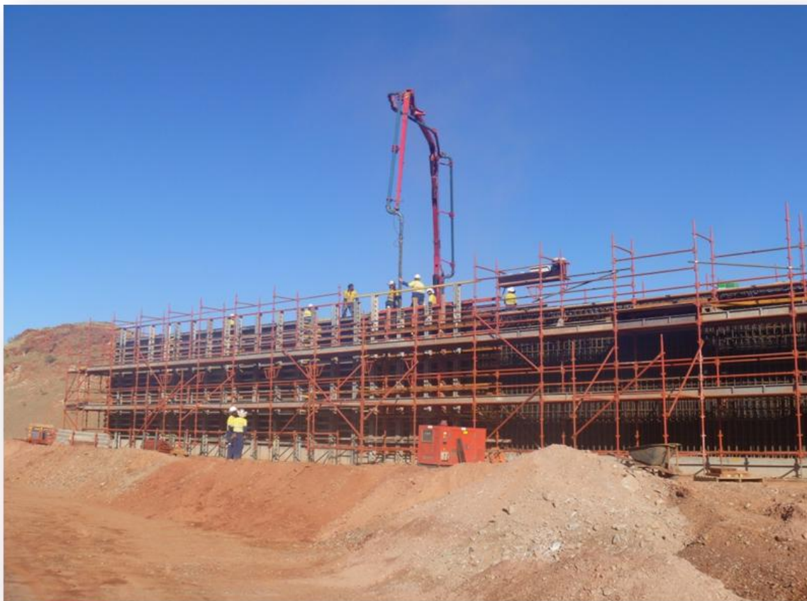
Reclaim tunnel concrete pour
