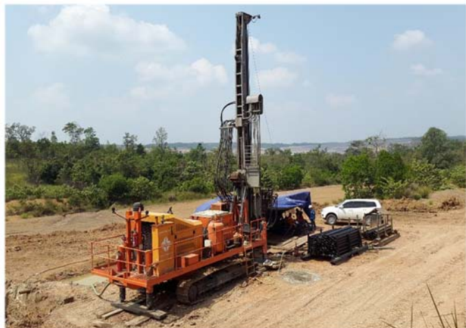
Rig Site at TE-008C
