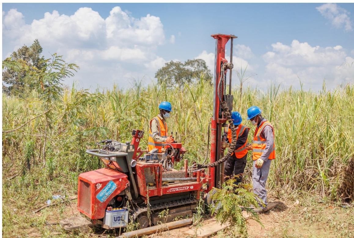
Figure 1: Geotechnical drilling underway at Makuutu.
