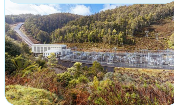
Hydro Tasmania's Tarraleah Canal
