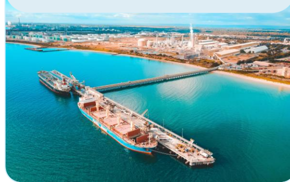
Kwinana Bulk Jetty
